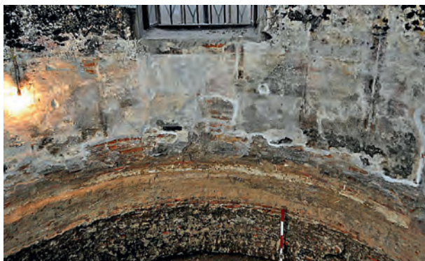
Zidul, centura și fundația absidei sudice
